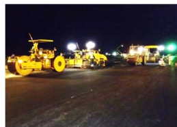
(老朽化した滑走路舗装の改良)
