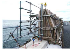
(護岸の高上げ)
