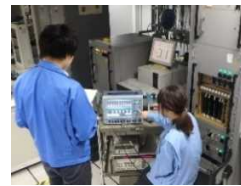
(航空保安施設点検実施状況)
