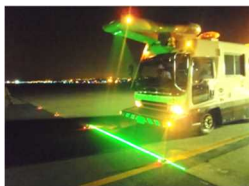
(基本施設点検実施状況)
