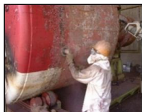
灯浮標の整備(錆落とし)
