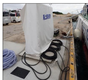
▲巡視船等に給電する設備を整備する。
