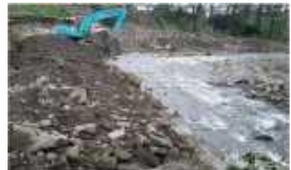
流路確保のための河道掘削状況
