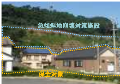
急傾斜地崩壊対策施設(新上五島町上五島地区 中筋)
