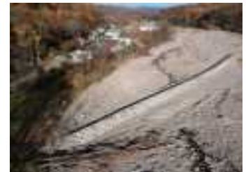
流路固定のためのブロック設置
