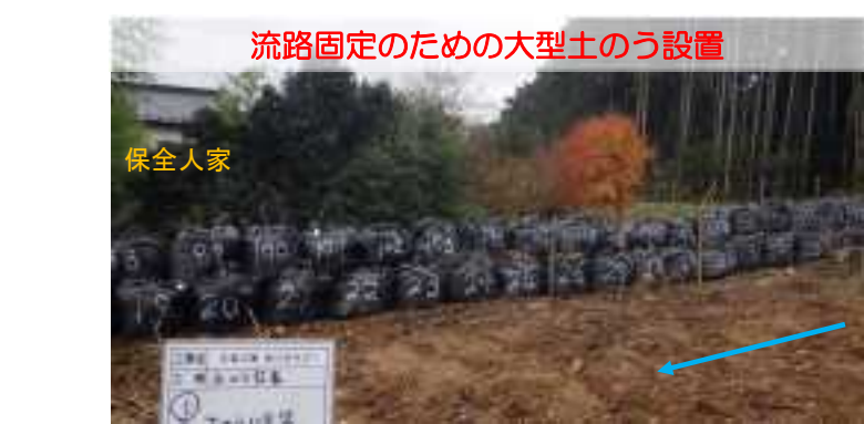
災関砂防の例(栃木県宇都宮市)
