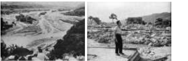
濁流にのまれた牧の原地区 (旧山梨県武川村 釜無川・大武川合流点) 土石流の被災箇所であらんと立ち尽くす住民 (旧山梨県武川村牧の原地区)
