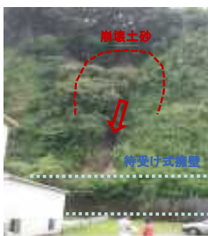
砂防関係施設が崩壊土砂を捕捉(鹿児島市坂之上地区)
