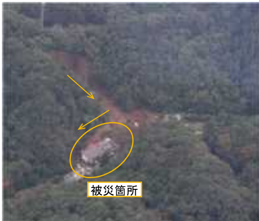
崩壊箇所全景
