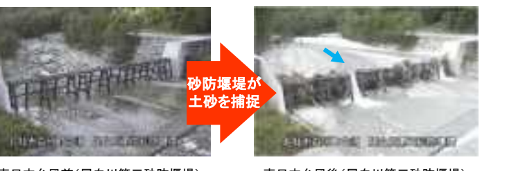
東日本台風前(尾白川第三砂防堰堤) 東日本台風後(尾白川第三砂防堰堤)
