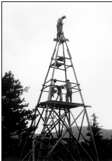
三角点間の視通を確保するため、高測標 (測量用の檣)を造標して、高所での 測量作業を実施
