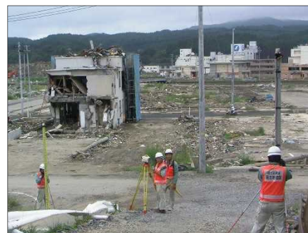
被災地での緊急水準測量 平成23年(2011年)東北地方太平洋沖地震
