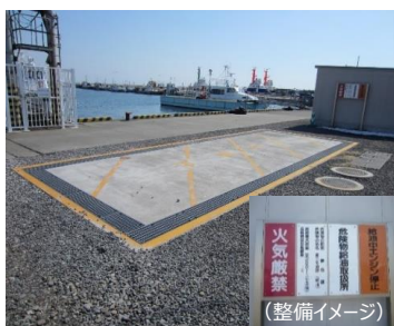
○燃料給油取扱所整備
