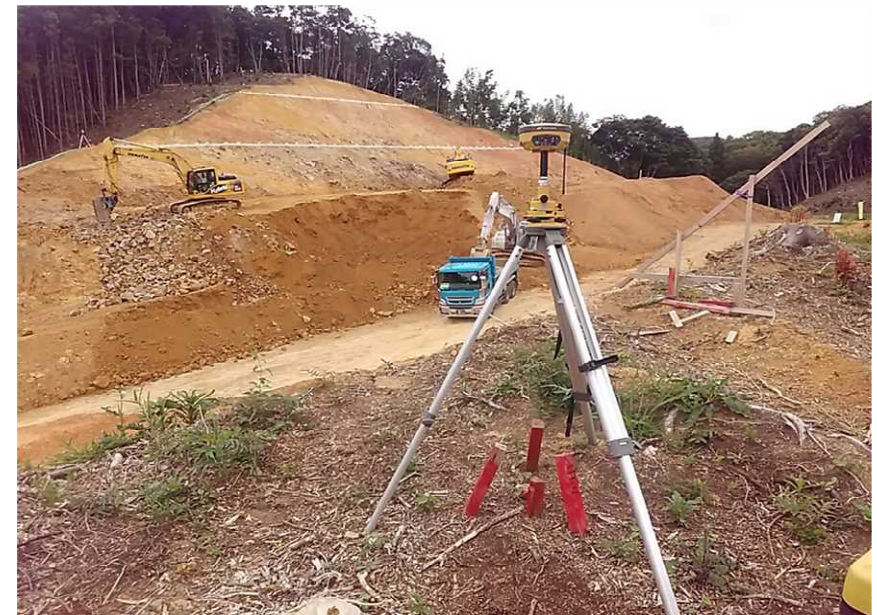
【3D-MCインテリジェントマシンコントロール GNSSシステムによる施工状況】
