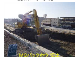
ICT機械による施工
