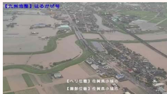
佐賀県小城市内における浸水被害状況
