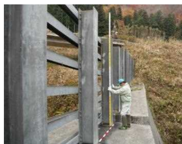
雪崩防止施設点検(岐阜県)
