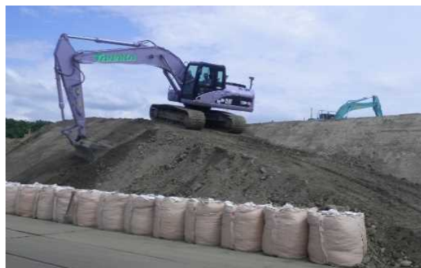
<仮設搬入路の築造>
