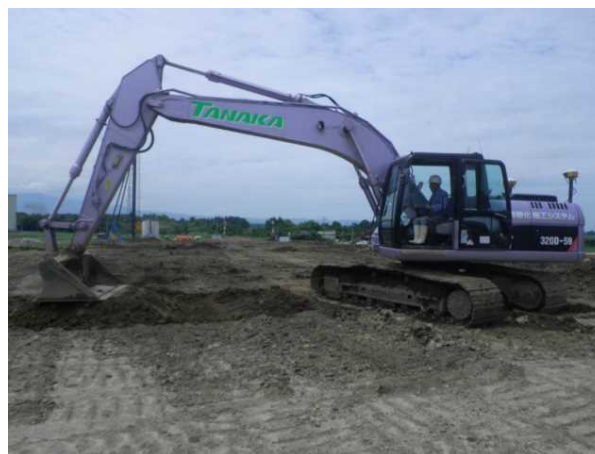
<ICTバックホウによる層毎の高さ設置>
