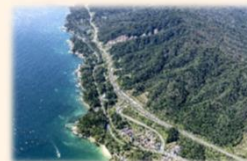
三陸沿岸道路 (岩手県山田町)
