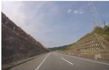
新東名 暫定4車線区間 (愛知県区間)
