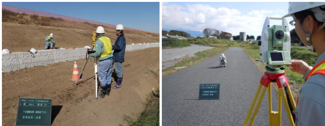
TSを用いた出来形管理実施状況
