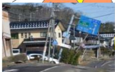
内灘町西荒屋地内（液状化）
