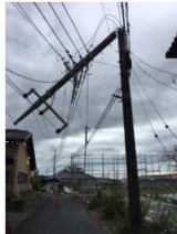
電柱の倒壊による配電設備の故障 （9/9撮影 千葉県多古町提供） （災害時気象報告より）
