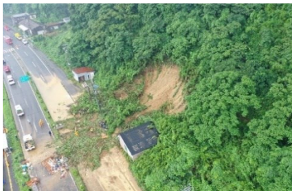
あきたし 国道7号の土砂流入 (秋田県秋田市)
