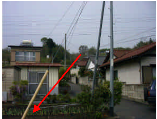
斜面にある住宅地の中をサイホンが通過
