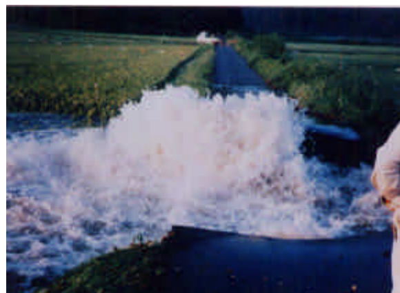
PC管破裂による出水状況 (木曾川用水)
