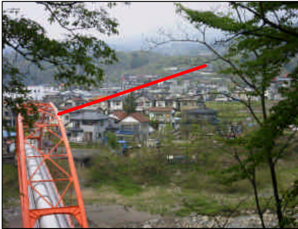
サイホン下流から上流を望む
