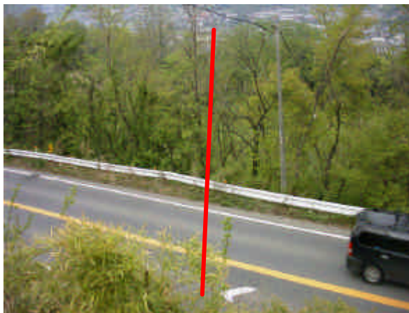
サイホン下流側県道下を通過
