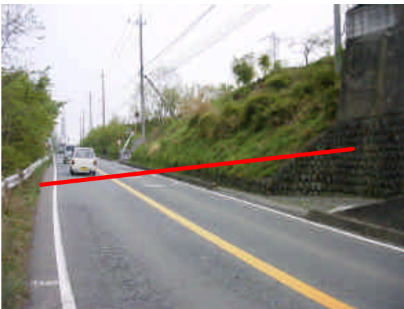
サイホン下流側県道下を通過
