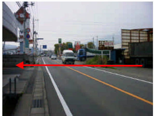
国道 353号をサイホンが横断
