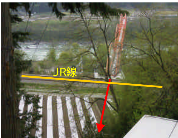
下流側から望む サイホン上部を上越線が通過
