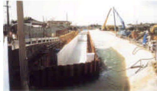
幹線水路等施設改築の施工状況
