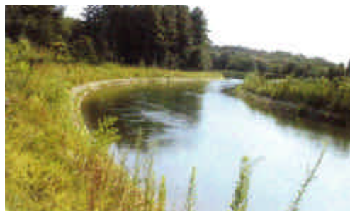
自然環境に配慮した水路
