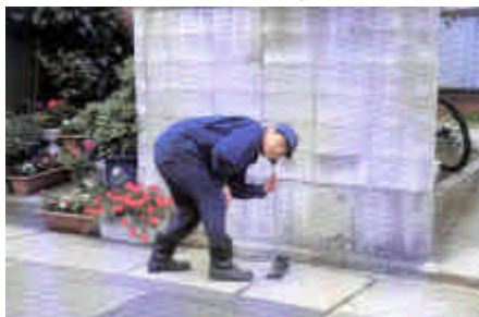
聴音棒による漏水調査
