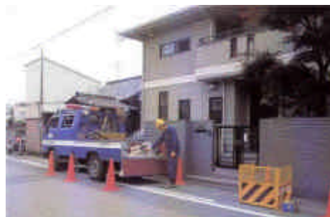
漏水探知装置による漏水調査
