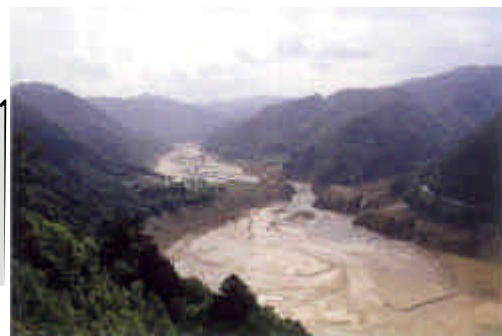
牧尾ダムの堆砂状況(H6.7)
