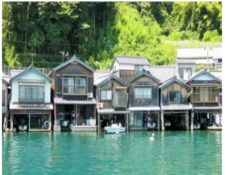
舟屋をカフェ・宿に改装して運営 (伊根 油屋の舟屋「雅」)
