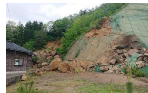
がけ崩れによる被害(石川県珠洲市正院町)
