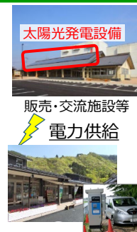
EV車等への給電設備
