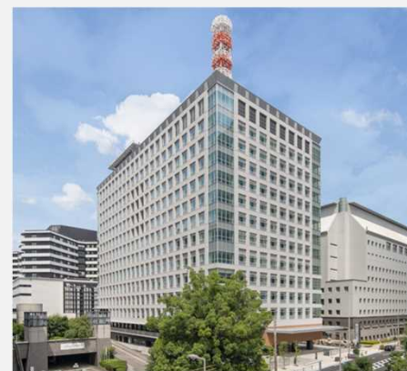
【大手前合同庁舎】
