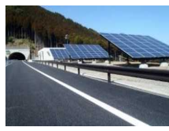
道路における太陽光発電施設活用
