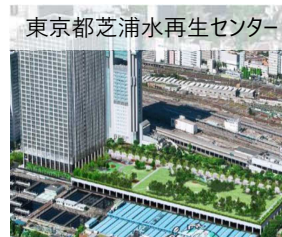
下水道(民間収益施設併設)
