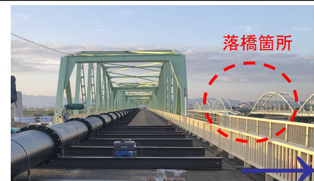
六十谷水管橋落橋状況 (和歌山県国道事務所CCTV)
