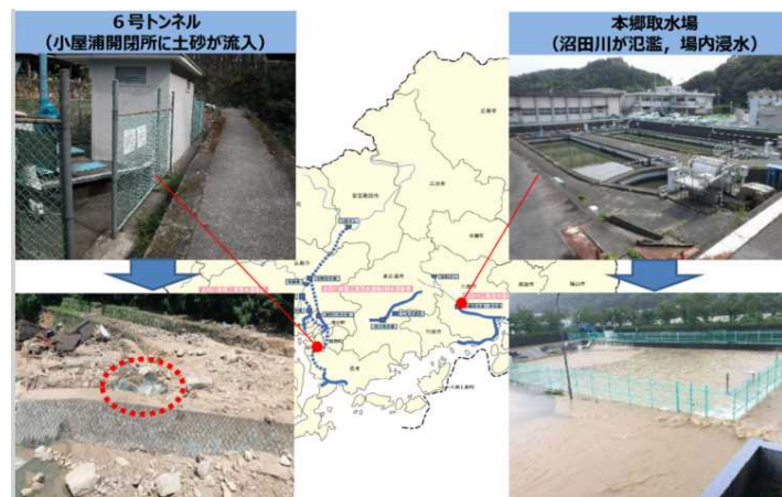
広島県工業用水の被災状況 1)
