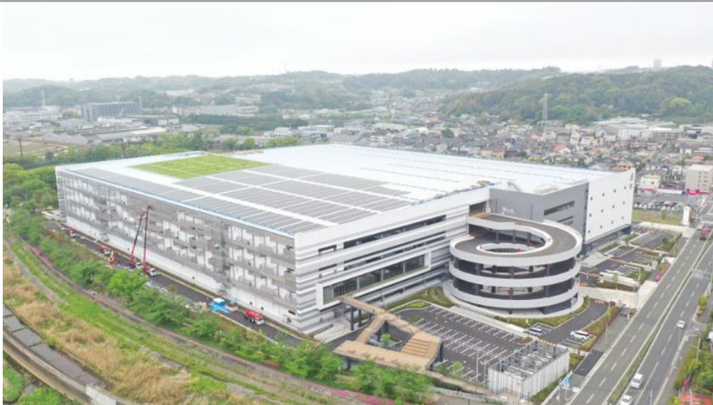
マルチテナント型物流施設（DPL横浜戸塚）
