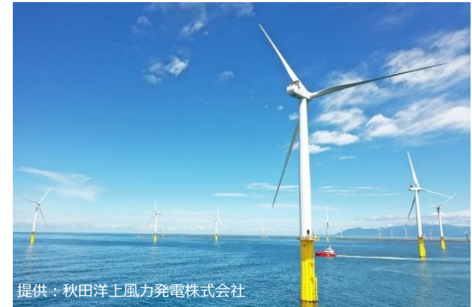
着床式洋上風力（秋田県 能代港内・秋田港内）※写真は能代港
