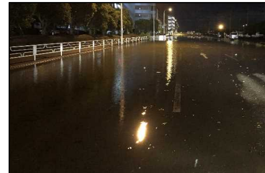
高潮による浸水 (神奈川県横浜市)
