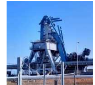
荷役機械の倒壊(相馬港)
