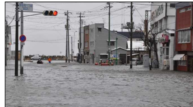
高潮による浸水 (北海道根室市)
