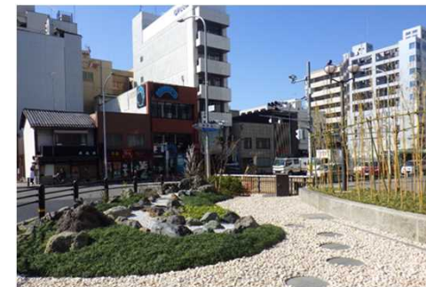
雨水を貯留浸透する雨庭 (京都市 四条堀川交差点)
