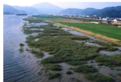
河道掘削による湿地再生 (兵庫県豊岡市 円山川)
