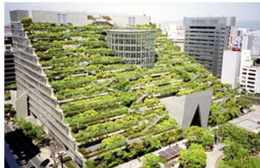
建築物の屋上緑化の例(福岡市)
