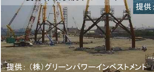
北九州港におけるジャケット製作作業状況(2022.7)
