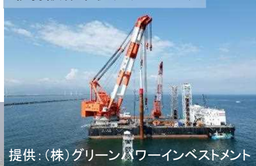
杭打設作業状況(2022.7)
