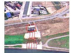
【耐震性能の不足】
