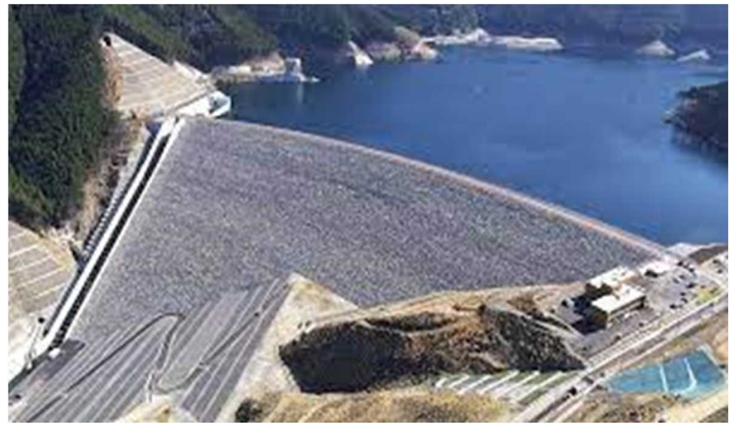
小石原川ダム
