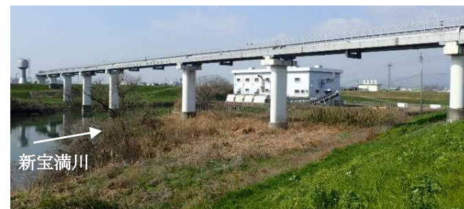
思案橋水管橋
