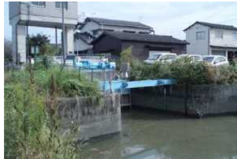
田川城島2号排水樋門
