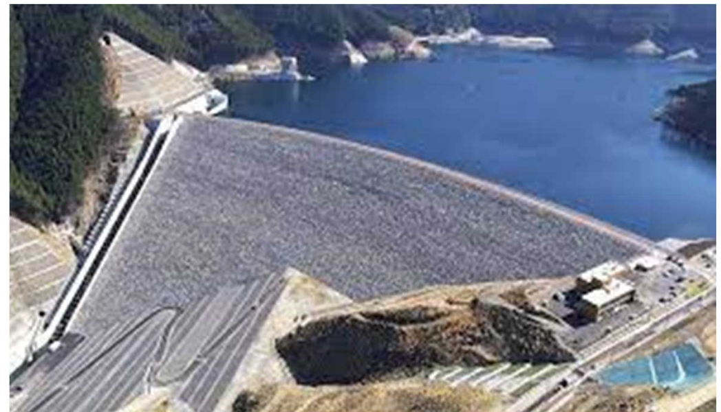
小石原川ダム
