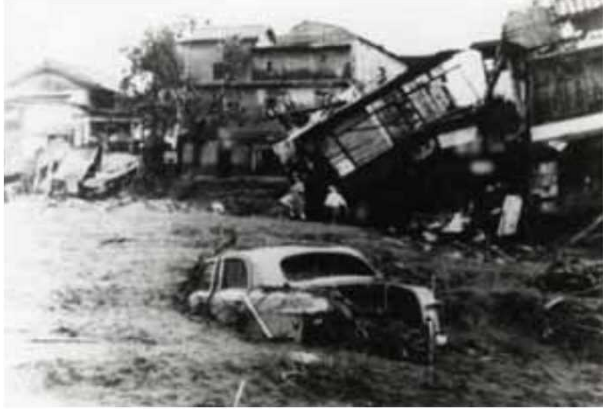
昭和28年6月洪水(福岡県朝倉市) 大きな被害を受けた原鶴温泉街
