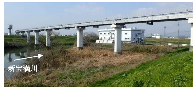
思案橋水管橋
