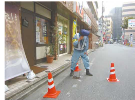
音響棒を使用した漏水調査(福岡市)
