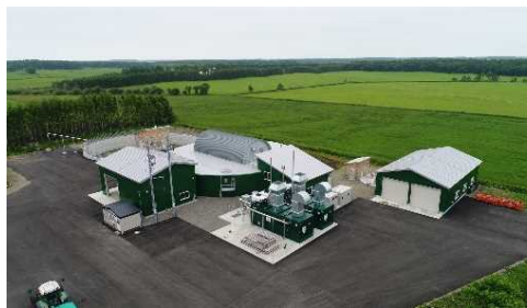
バイオガスプラントの整備
