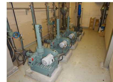
農業集落排水施設の整備(ポンプ設備の更新)
