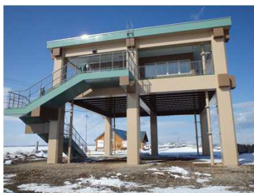
津波避難タワーの整備
