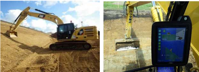
道路の新設工事におけるICT建設機械での切土法面の掘削状況
