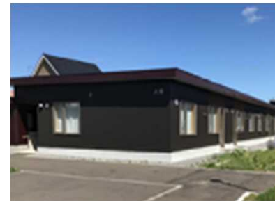
道産材を活用した道営住宅(余市町)
