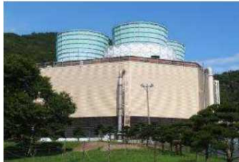
北海道電力(株) 森地熱発電所
