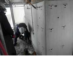
鉄板接着工法による頭首工の耐震対策
