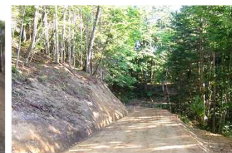
森林施業を行うために、主に林業機械の走行を想定した「森林作業道」
