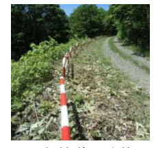
既存林道の改修 (防護施設設置)
