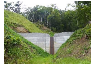
増大する山地災害に対応するため、治山ダムを設置
