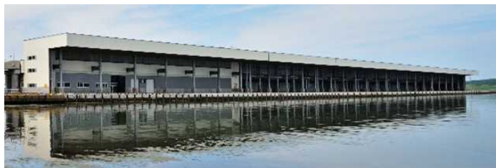
厚岸漁港衛生管理施設全景
