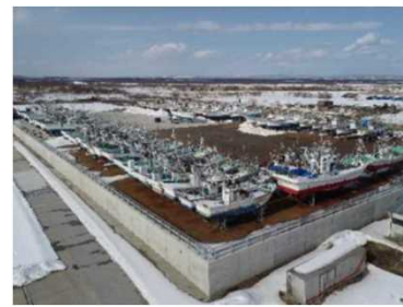
用地のかさ上げによる地震・津波対策
