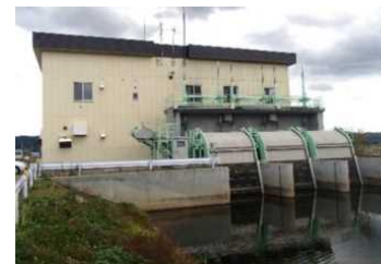
降雨形態の変化による排水量の増大に対応するため、排水機場を整備
