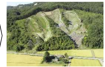
林地の復旧対策後 (令和3年9月)
