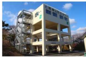
津波避難タワーの整備事例 (積雪寒冷を考慮した防寒機能付)
