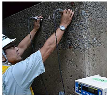
非破壊試験(表面走査法)による凍害点検
