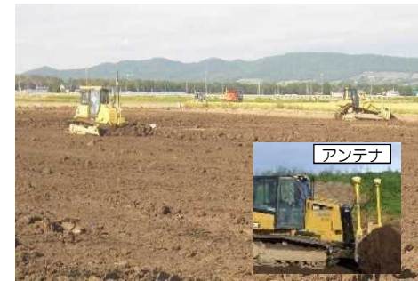
GNSSを活用した整地工の状況
