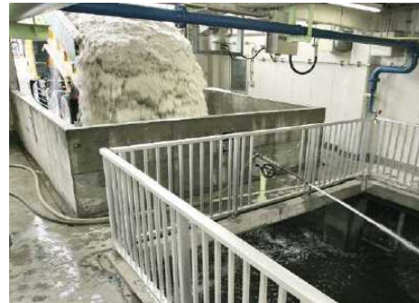
融雪槽への投雪状況
