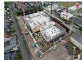
水道施設の耐災害性強化事例
