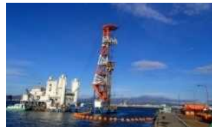
耐震強化岸壁の整備事例
