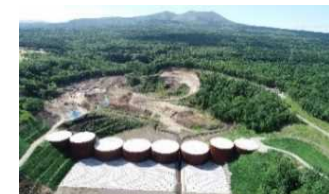
砂防堰堤の整備事例
