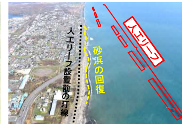
高潮等による浸水被害を防止する防波堤や人工リーフの整備
