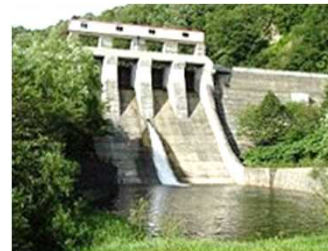
洪水被害軽減等に向けた既設ダムの再生（堤体嵩上げ等）
