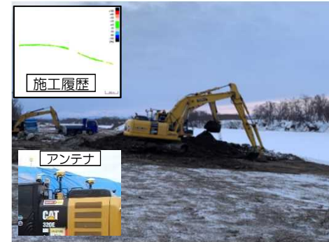
施工履歴を用いたICT施工
