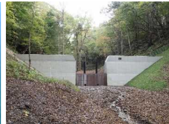
土砂流出を抑制し山地災害を防ぐ治山ダムの整備
