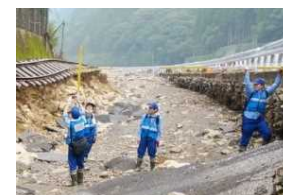
被災状況の調査 (令和2年7月豪雨・熊本県芦北町)
