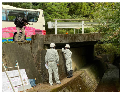
直営点検の状況
