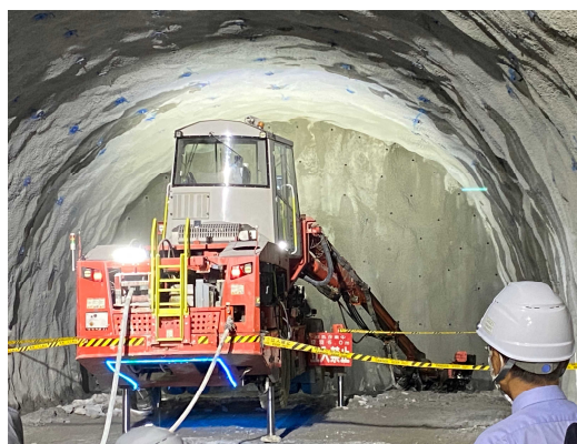
岩の削孔の状況
