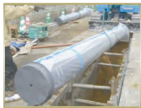
ポリエチレンスリーブ装着状況
