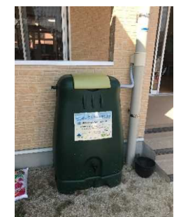
雨水貯留タンクの設置状況(福岡県)
