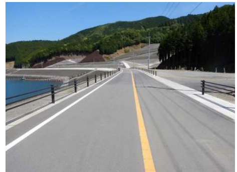
道路改良事業 (小石原川ダム)
