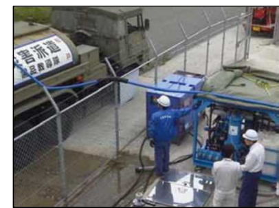
可搬式浄水装置から自衛隊車両に給水
