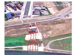
【耐震性能の不足】
