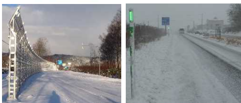
防雪柵の整備
