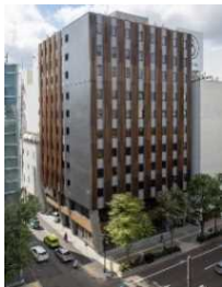
道産CLTを使用した高層ハイブリッド木造ホテル
