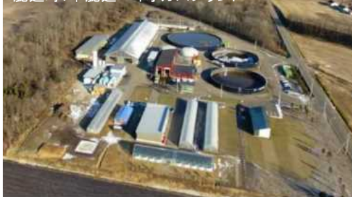
鹿追町:中鹿追バイオガスプラント
