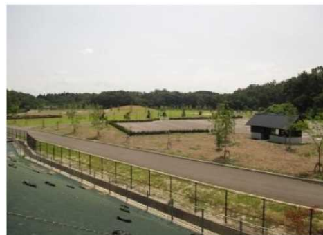
自然公園の保護又は利用のための施設の整備に関する事業（大山ダム）
