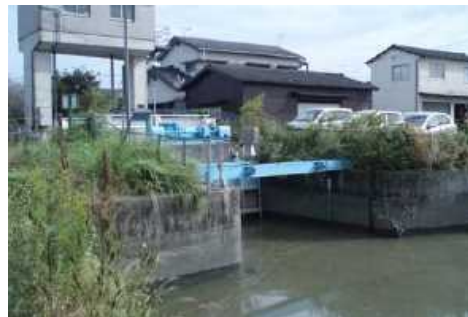
田川城島2号排水樋門
