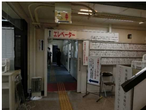
大分税務署:2号館にエレベーターが未整備(2号館3階の相談窓口等へは、高齢者なども階段で移動せざるをえない)
