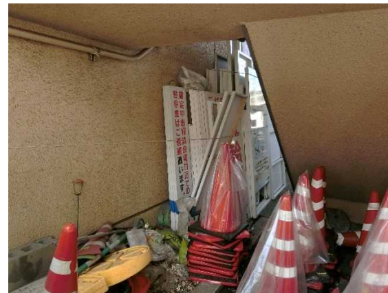
屋外：倉庫が不足しており、 屋外階段下まで備品が溢れている
