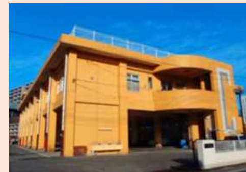
補助事例: 久留米市環境部庁舎(福岡県久留米市)
