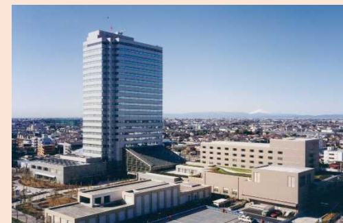
補助事例: 光が丘「J.CITYビル」ZEB Ready化総合改修事業 (東京都練馬区)
