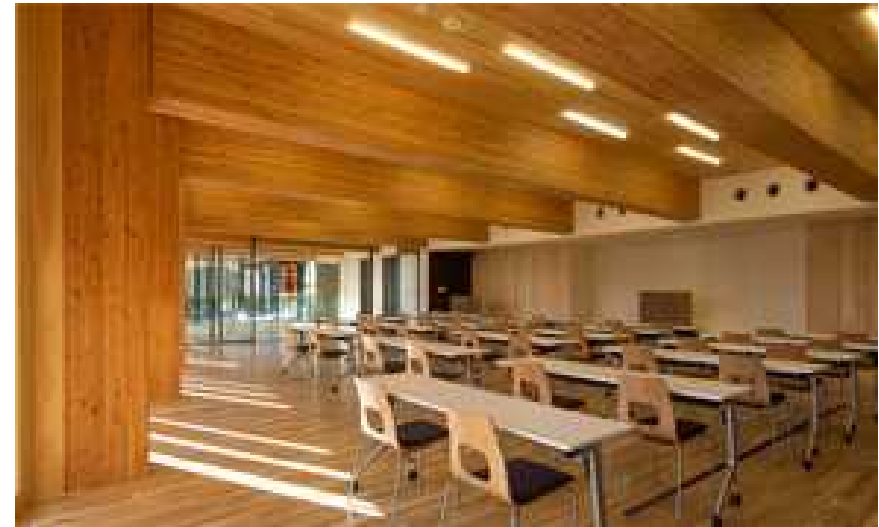
大阪木材仲買会館、木造・RC造等、最上階(3階)会議室、耐火構造、設計:竹中工務店
