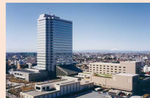
補助事例:光が丘「J.CITYビル」ZEB Ready化総合改修事業 (東京都練馬区)
