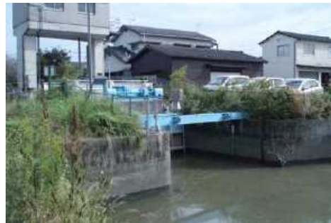
田川城島2号排水樋門
