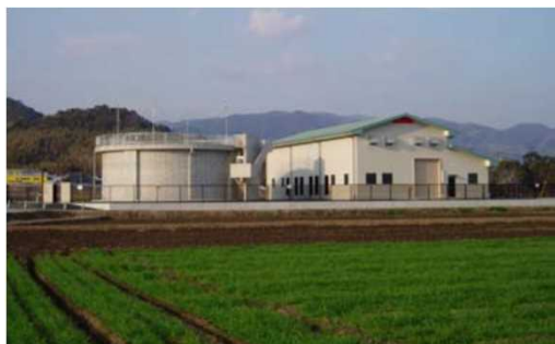
城原金立揚水機場
