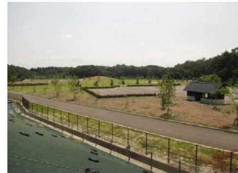
自然公園の保護又は利用のための施設の整備に関する事業（大山ダム）
