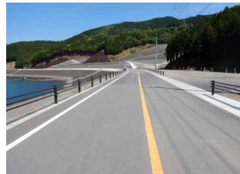
道路改良事業（小石原川ダム）
