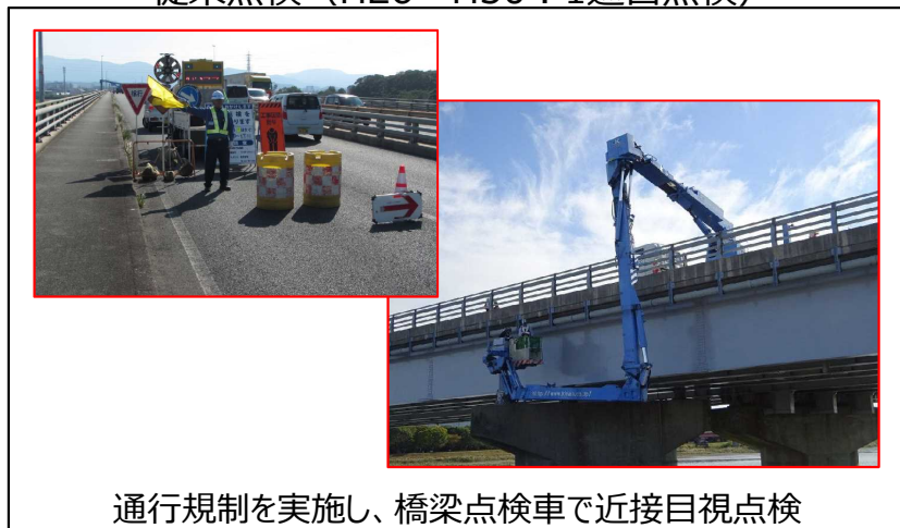
従来点検 (H26~H30 : 1巡目点検)
