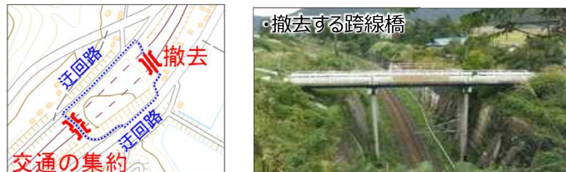
老朽化が進展した跨線橋を撤去し 隣接橋へ機能を集約
