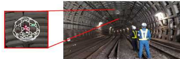
ドローンを活用したトンネル検査(イメージ)
