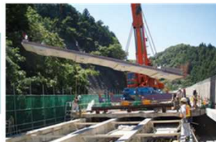
床版の取替 (約79百万円/330m 2 ) ※施工期間は、約160日
