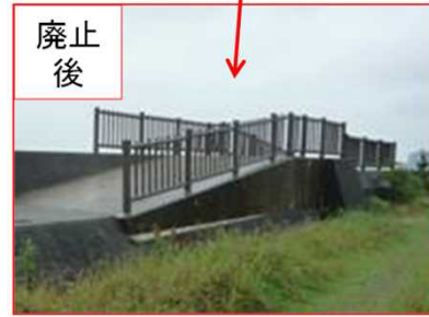
スロープを設置し陸閘を廃止
