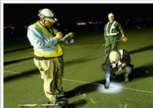
<ひび割れ計測>
