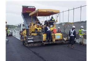
遮水、防水補修 (約2.2百万円/330m 2 ) ※施工期間は、約7日
