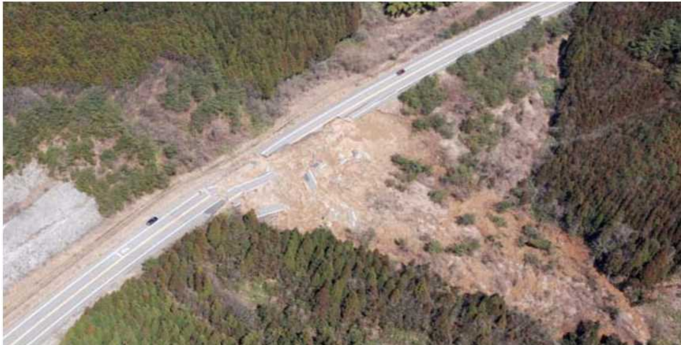
傾斜地盤上の高さ20~25mの盛土
