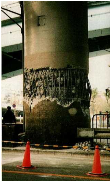
鉄筋コンクリート橋脚
