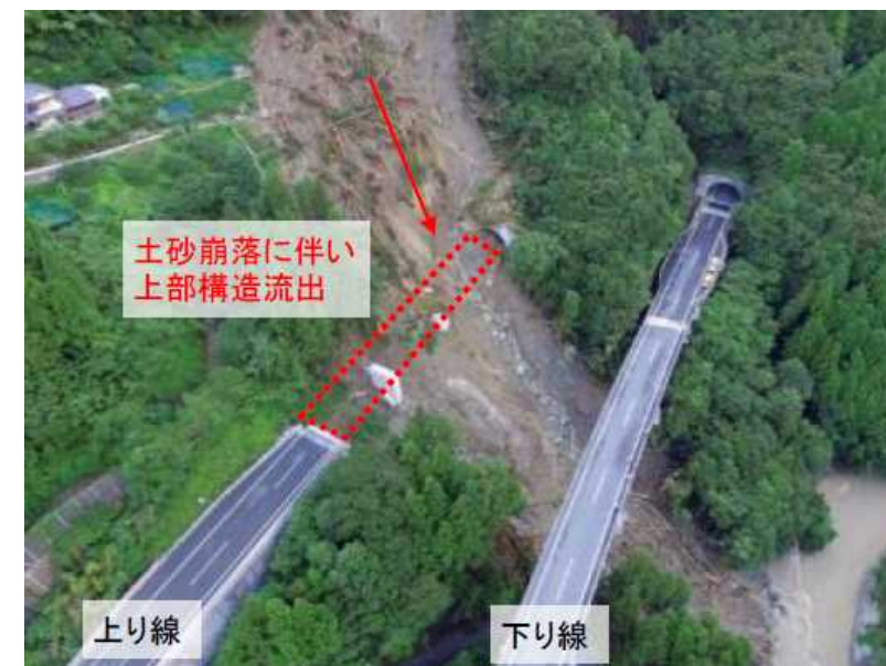
自然斜面の崩壊
