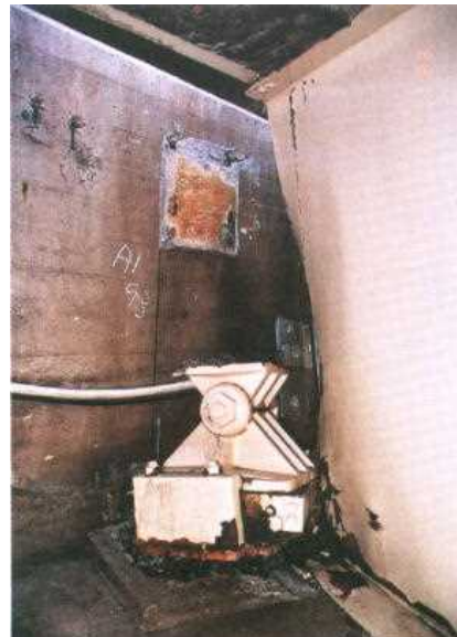
支承高が高い鋼製支承
