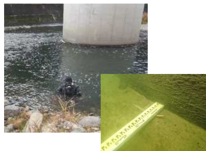
潜水調査による河床洗掘の把握
