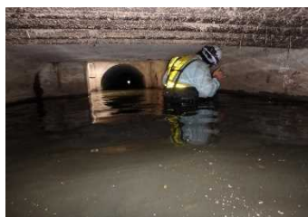
滞水した溝橋内部の目視点検
