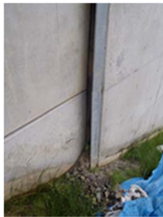
写真 土砂のこぼれ出し例
