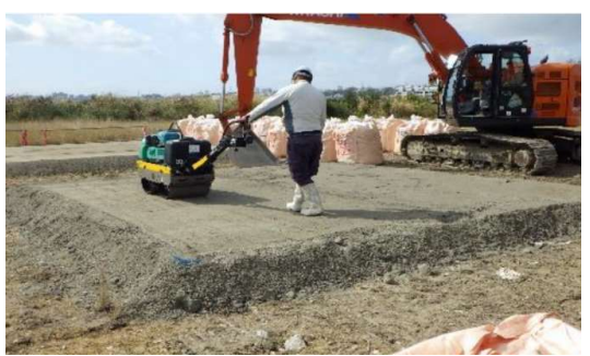
試験体の敷均し・転圧の様子
