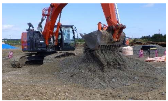
軽石と浚渫土砂の混合状況
