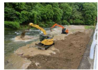
フラッシュ放流・土砂還元 の状況
