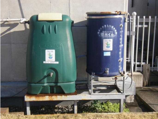
雨水貯留タンク設置状況
