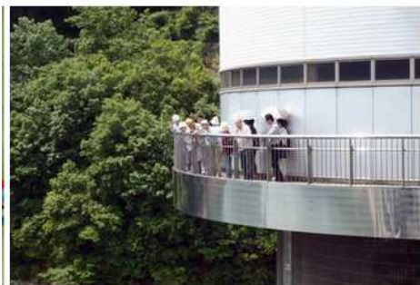
日吉ダム選択取水設備
