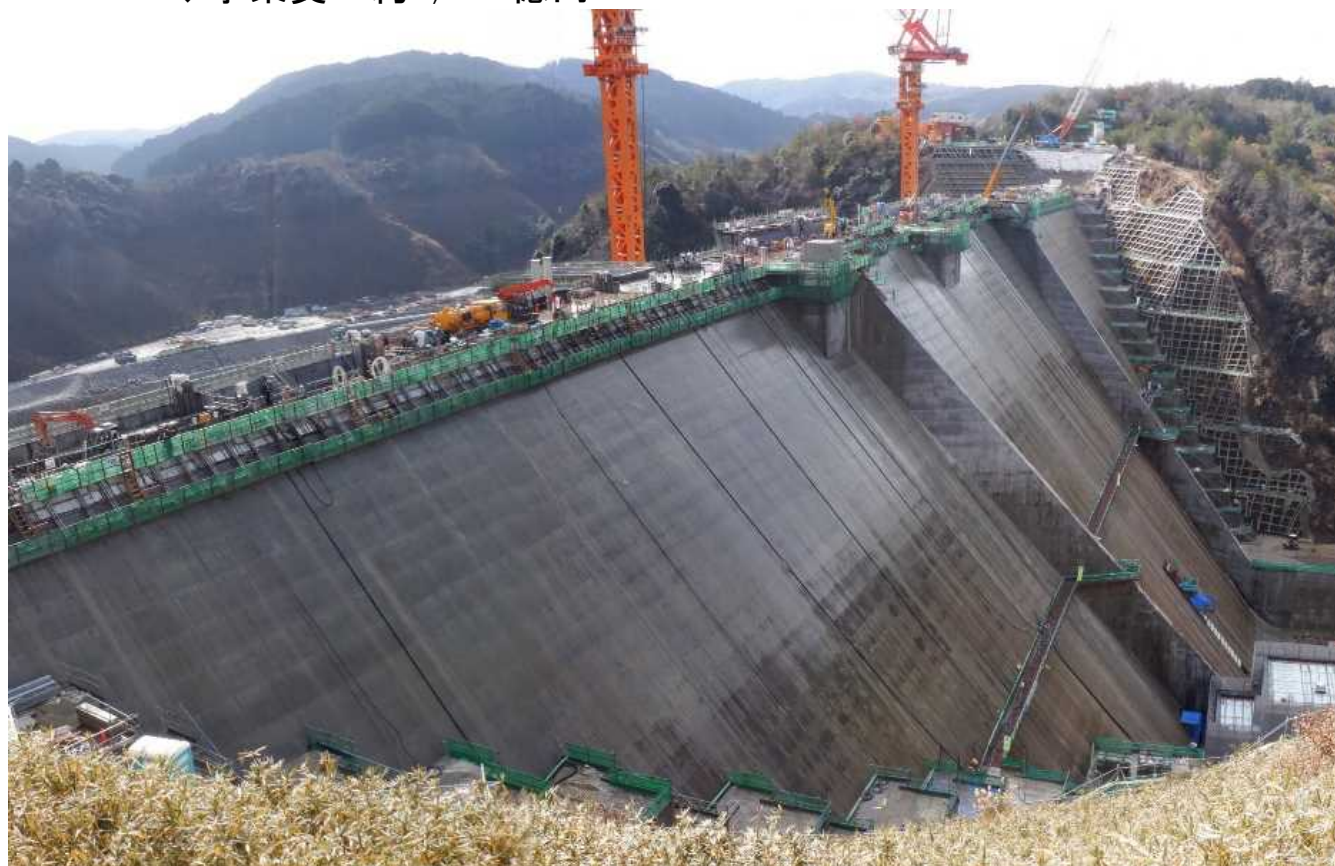
ダム本体の施工状況(ダム右岸側より)(R3.1.末)
