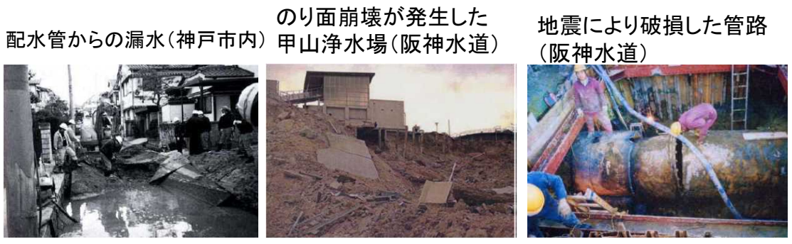
配水管からの漏水(神戸市内) 出典: 阪神・淡路大震災水道復旧の記録(神戸市水道局) のり面崩壊が発生した甲山浄水場(阪神水道) 出典: 阪神・淡路大震災と水道(財団法人水道技術研究センター) 地震により破損した管路(阪神水道)
