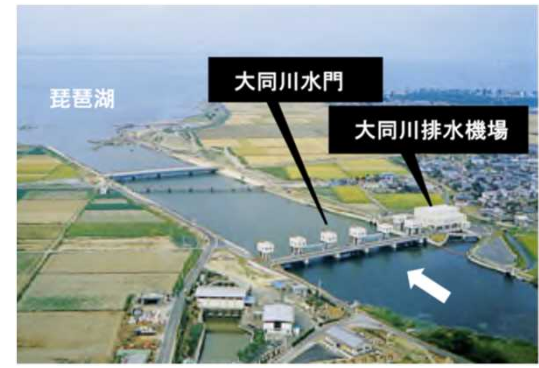
内水排除施設(14箇所)
