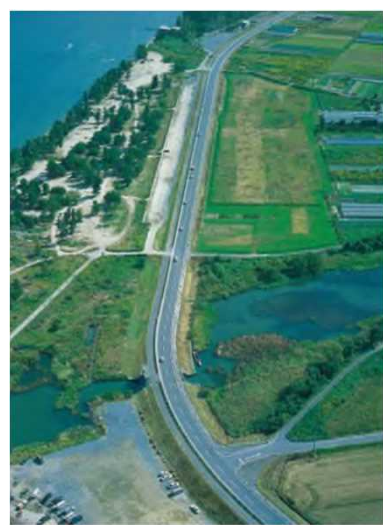
湖岸堤・管理用道路の建設(50.4km)
